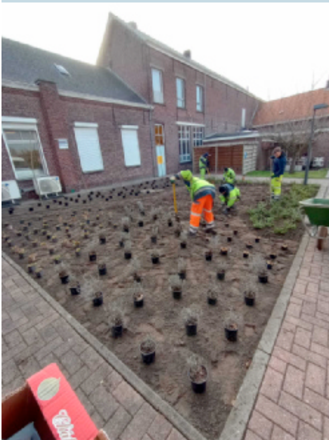
Aanleg door MITRO
